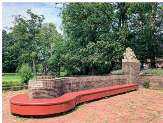
De Juliana en Bernhardbank in Voorburg. 1937-1938 (foto: auteur)
